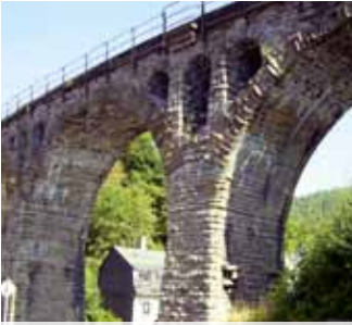
Überspannung des Tales durch Viadukt
